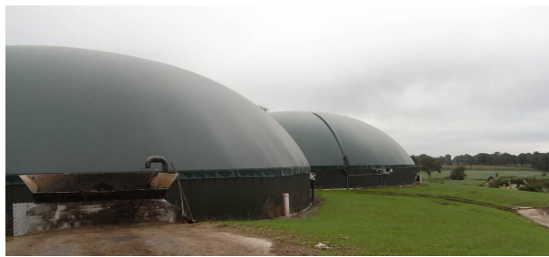
Figur 10: Sauter-anlæg. Forreste tank er primærreaktor med indfødningsstragt. Spuledyser på siden af reaktorer.
